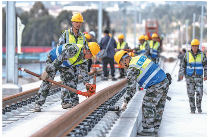
工人在渝昆高铁施工现场进行铺轨作业 本版图片 新华社记者 胡超 摄
