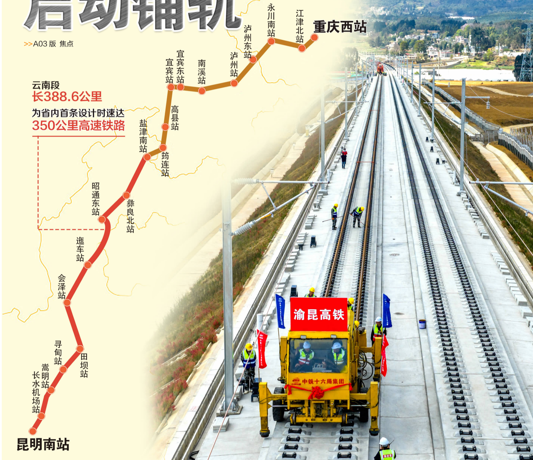
3月18日在嵩明县拍摄的渝昆高铁施工现场(无人机照片)
