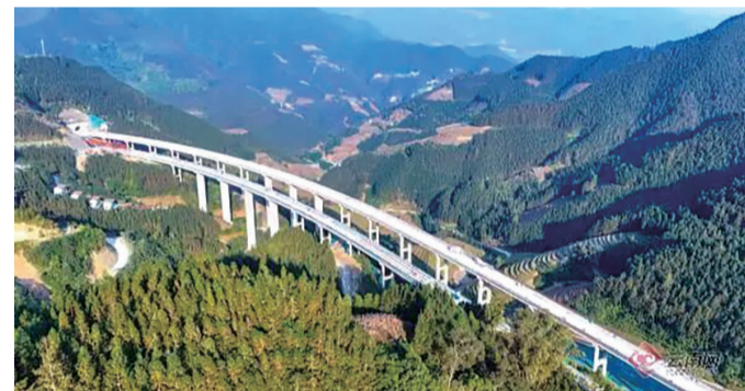
天麻高速畴阳河大桥
