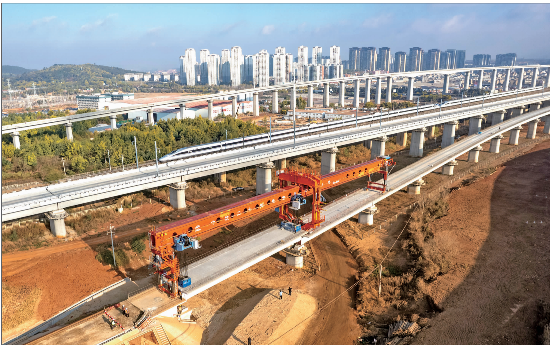
渝昆高铁最后一榀箱梁架设施工现场(无人机照片)
