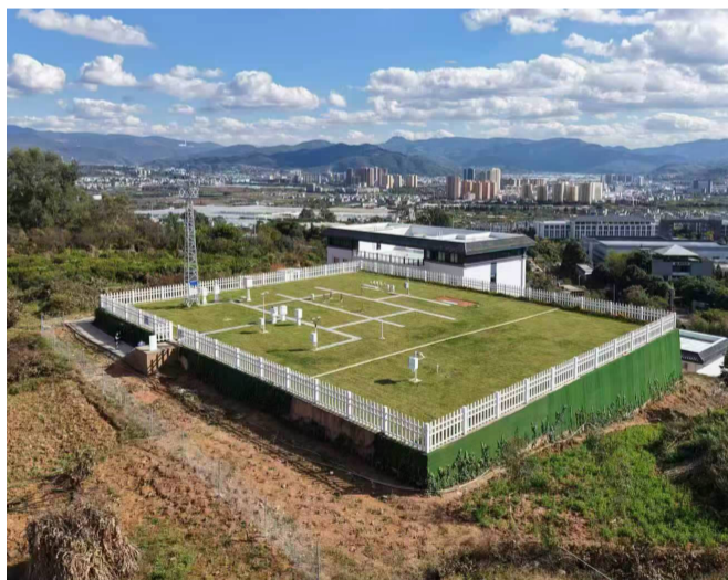
富民国家气象观测站新建工程顺利完工
