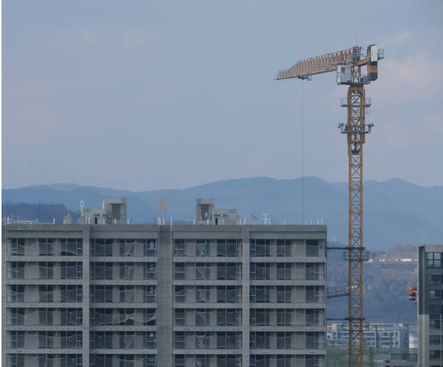
昆明建设中的商品房
