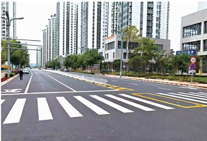
巫家坝片区 19 条道路已基本完工
