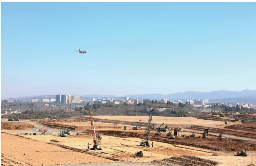
昆明机场改扩建工程正在紧张建设中
