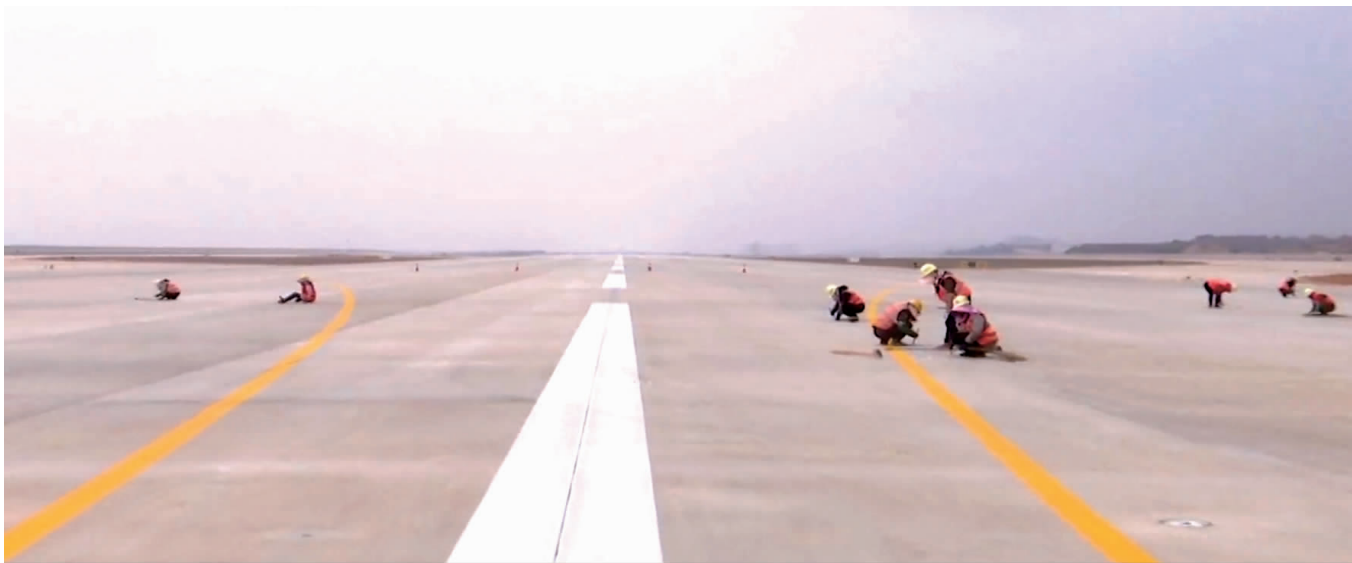
昆明机场改扩建工程东二跑道施工现场 视频截图
