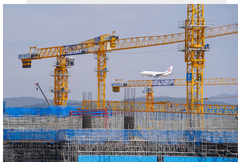
渝昆高铁长水机场站施工现场(2025年5月21日摄) 新华社记者 陈欣波 摄
