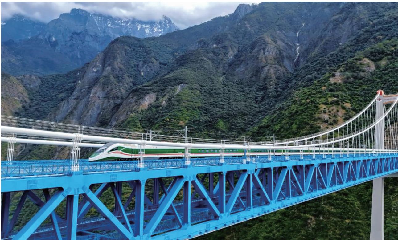
这是全长882.5米的虎跳峡金沙江铁路大桥。大桥起于玉龙雪山隧道出口，止于哈巴雪山隧道进口，是丽香铁路的重点控制性工程(2025年11月21日摄，无人机照片) 新华社发(杨紫轩 摄)
