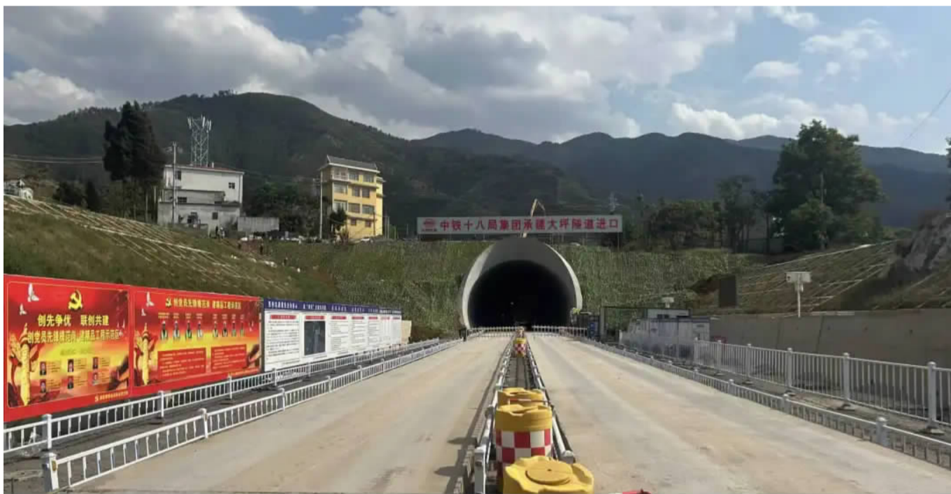
大坪隧道进口
