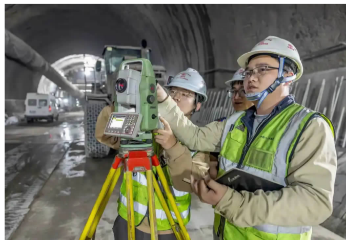
工作人员在隧道内勘测
