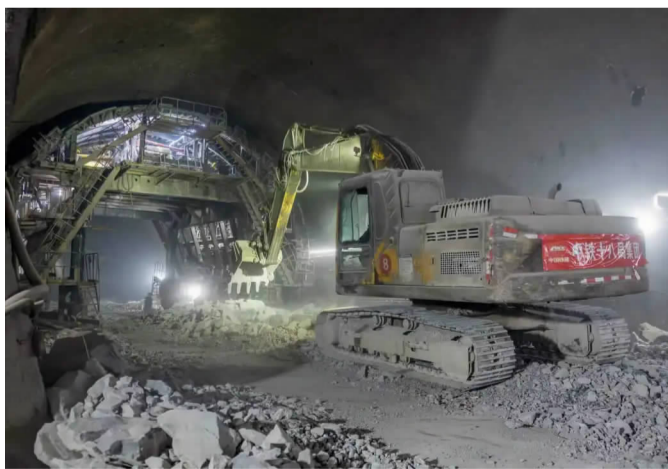
挖机在隧道内施工
