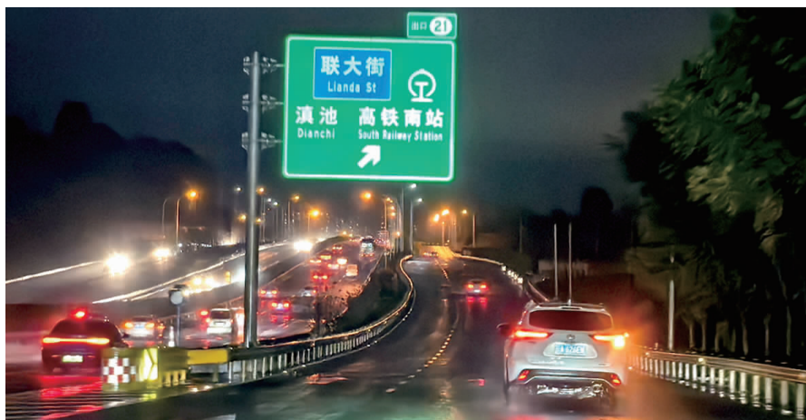
11月10日晚,联大立交匝道150组路灯全部复亮 都市时报全媒体记者 李锐
