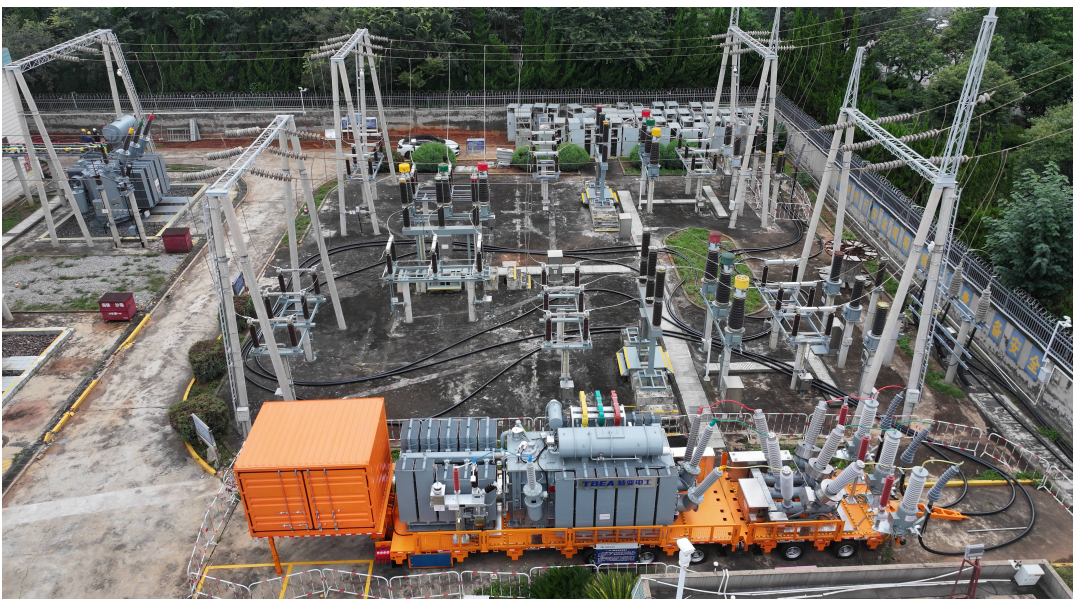
变电站改造现场 供图
