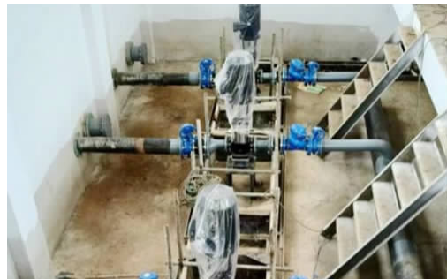
泵站设备安装
