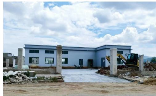
二级泵站建设
