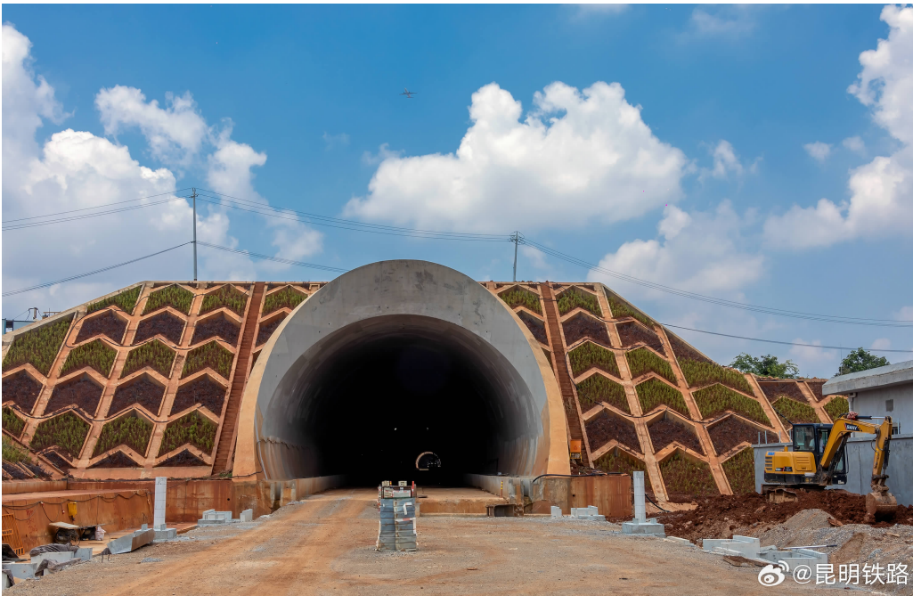
渝昆高铁长水机场隧道口
