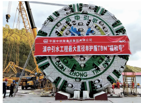
滇中引水工程最大直径盾构机启动试掘进
