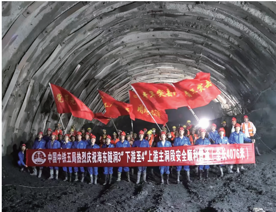
4076米长的海东隧洞主洞贯通
