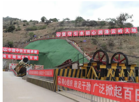
滇中引水工程建设顺利推进
