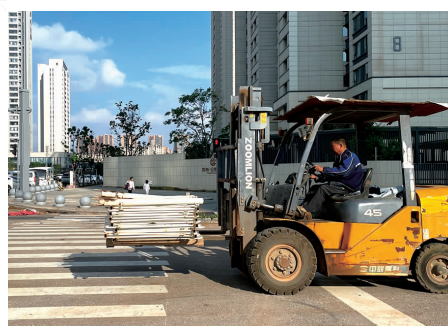
工人正在进行收尾工作
