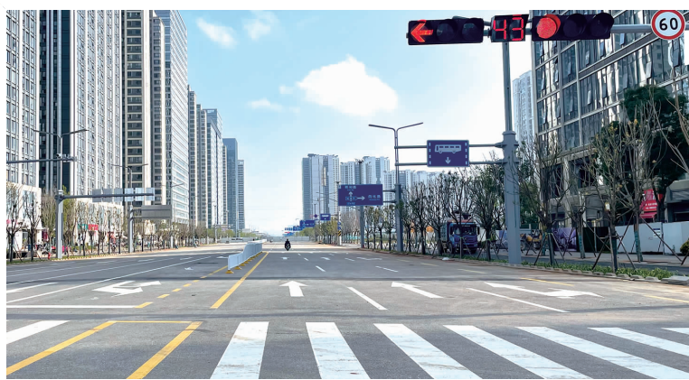
飞虎大道广福路至万德街段交通信号灯、路灯已经安装完成
