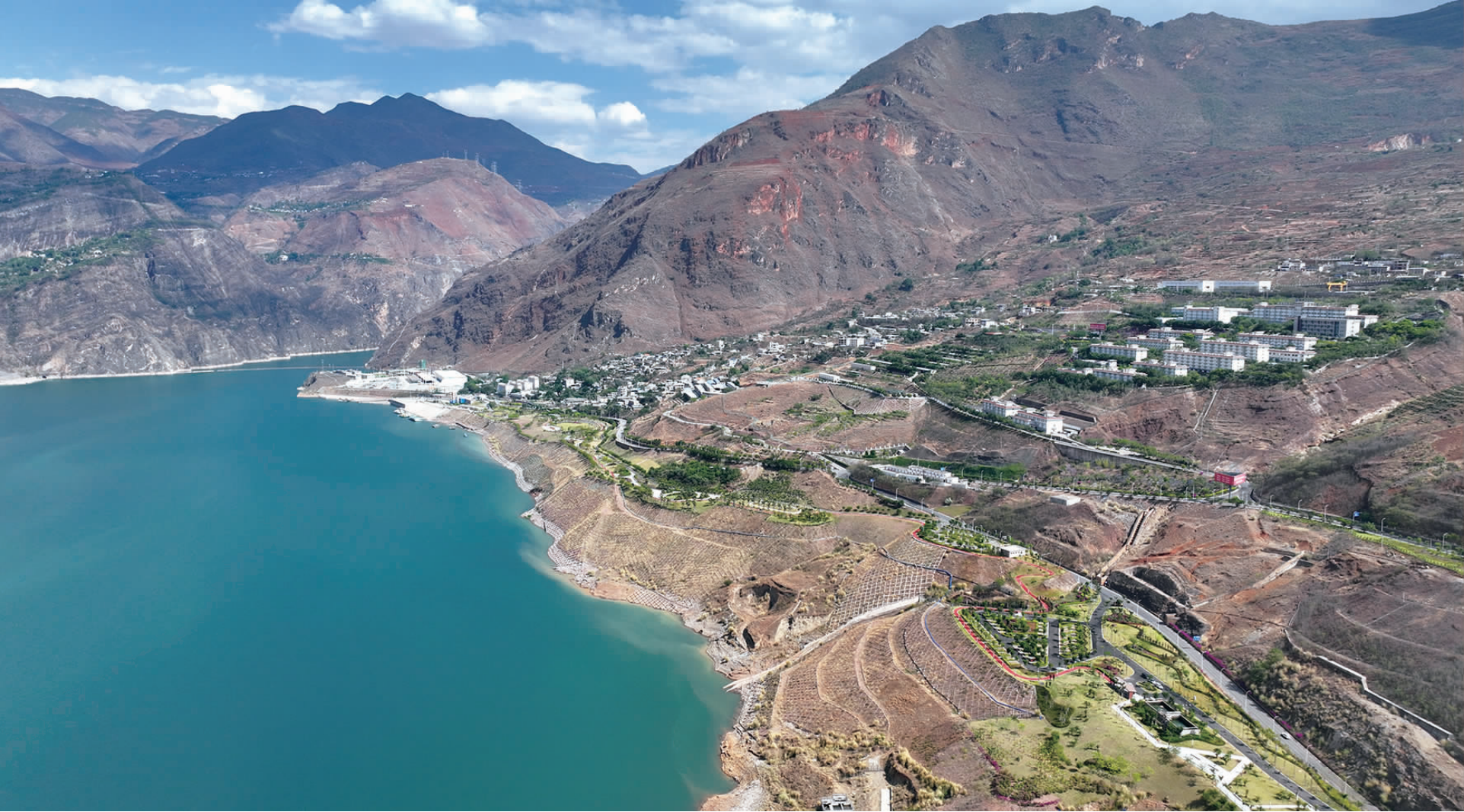
国家重点工程乌东德水电站库区 本版图片 都市时报全媒体记者 黄晓婧
