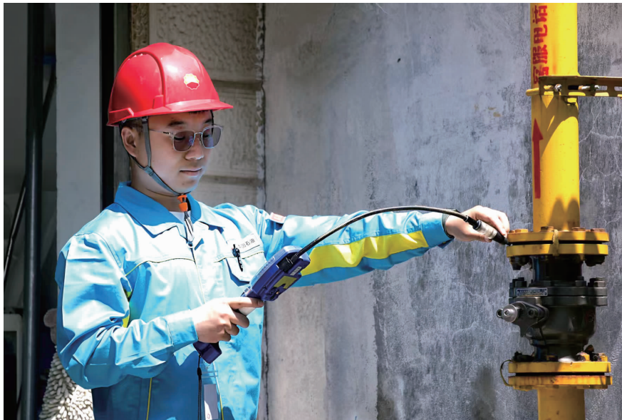
工作人员检查燃气管道 本组图片 供图
