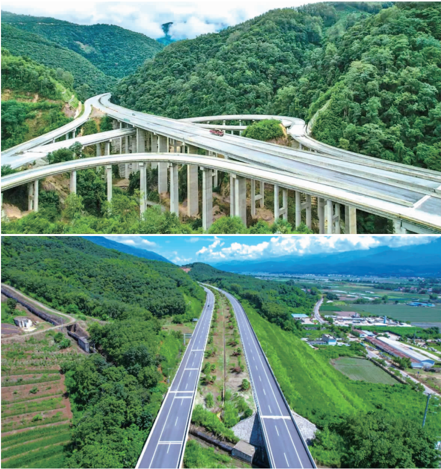
临沧临清高速公路
