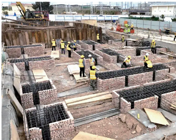
昆玉扩能改造项目施工现场
