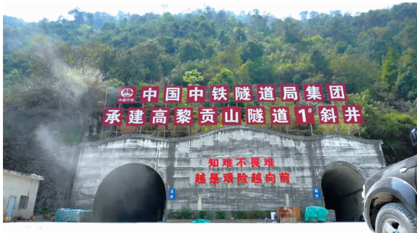
位于高黎贡山腹地的1号斜井入口
