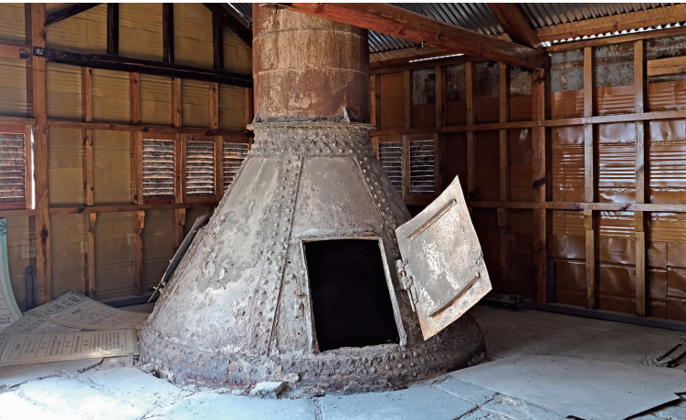
我国第一台自主安装的半机械立窑,筒体上部及平台支撑采用钢结构铆接
