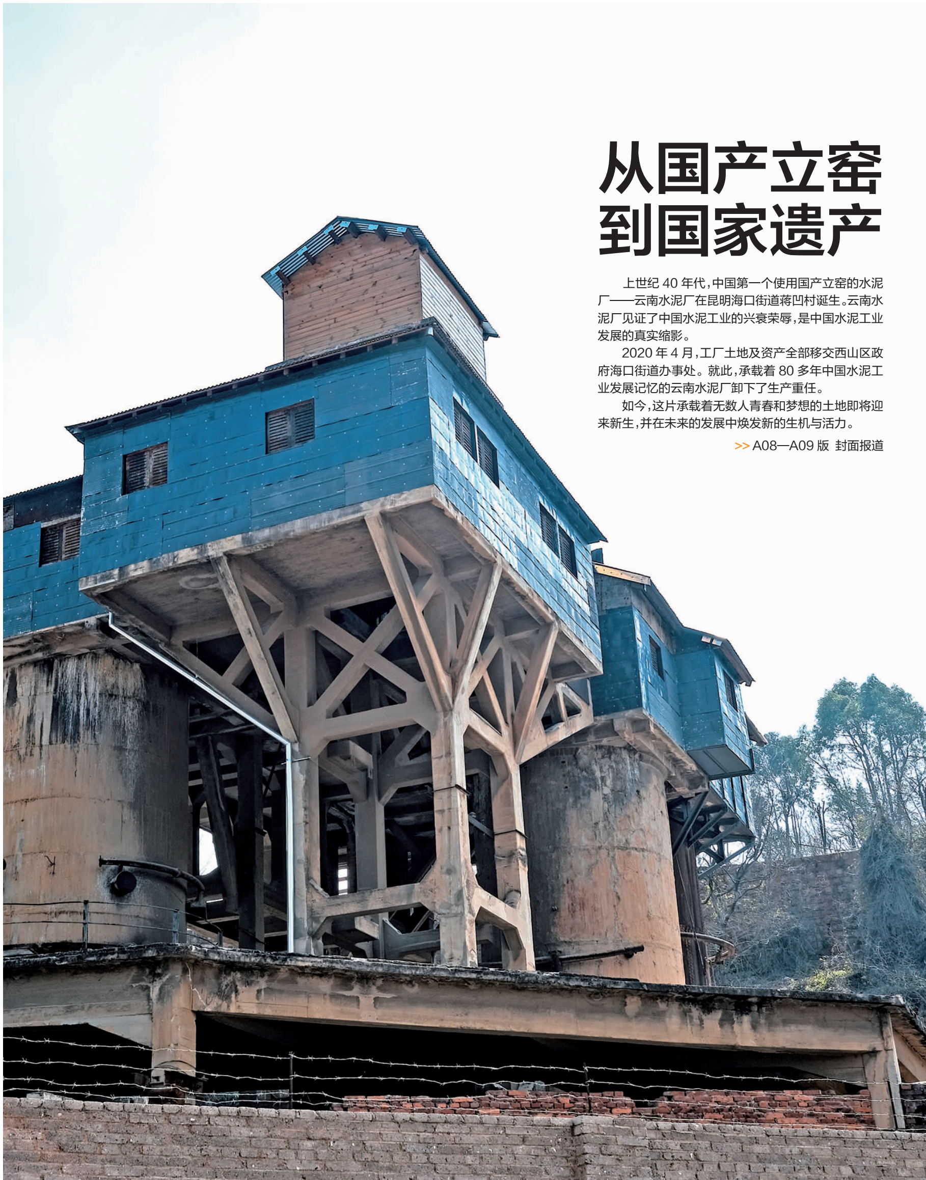
位于昆明海口街道蒋凹村的云南水泥厂立窑
