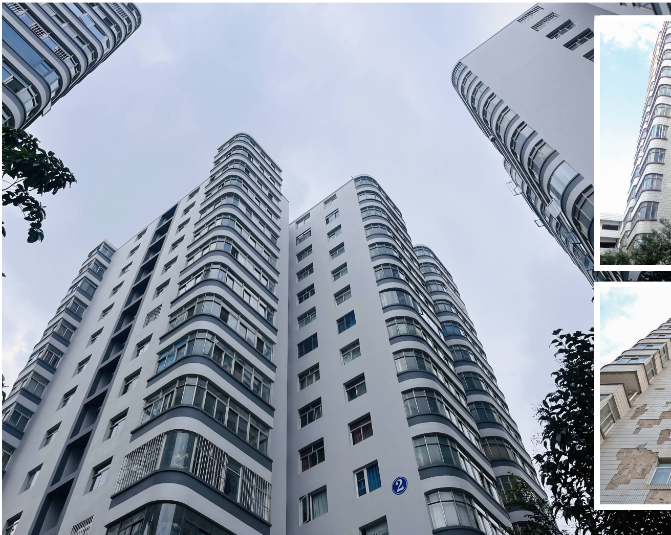
改造前的瓷砖外墙剥落严重
