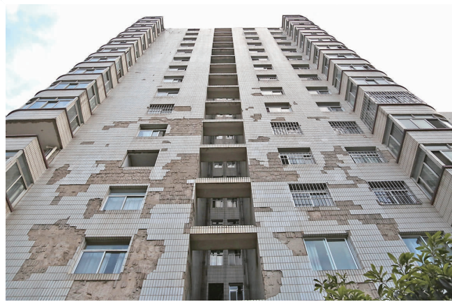
改造前的瓷砖外墙剥落严重
