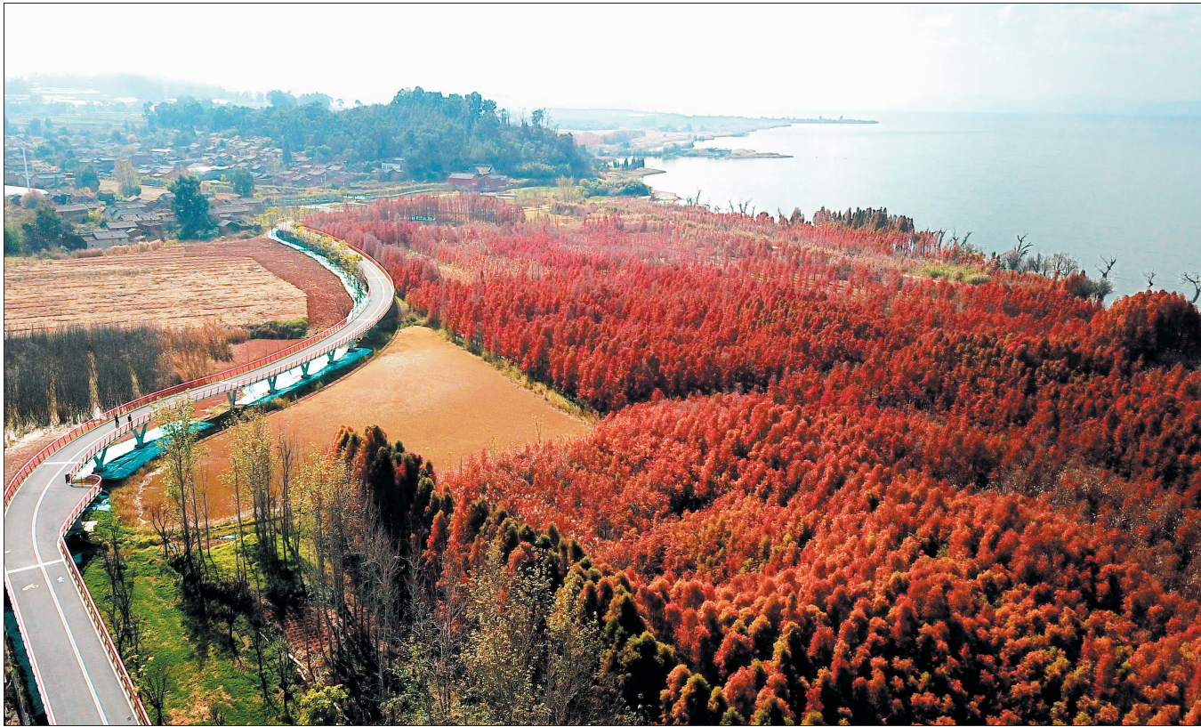
昆明滇池绿道建设项目（外海段）一期工程“水之桥”项目
