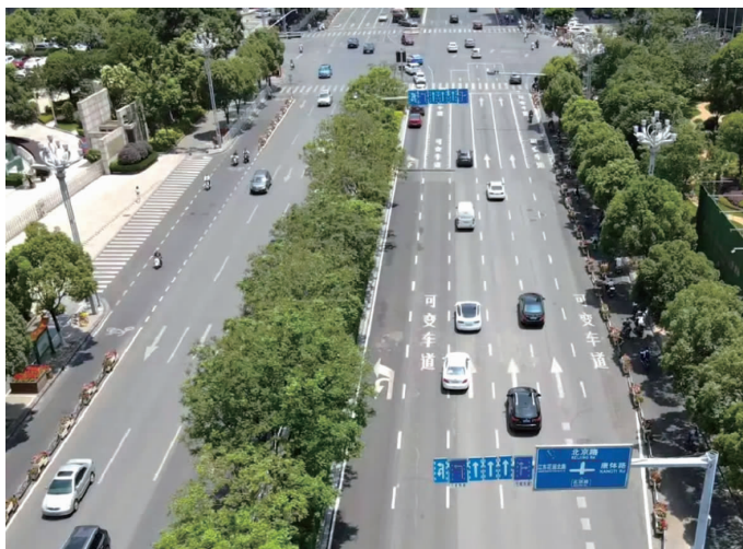
北京路与霖雨路交叉口“可变导向车道” 本版图片 资料图片
