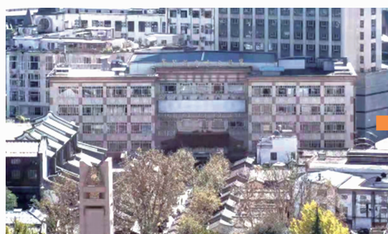
外立面修缮前
