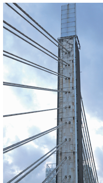
圆通大桥的斜拉索
