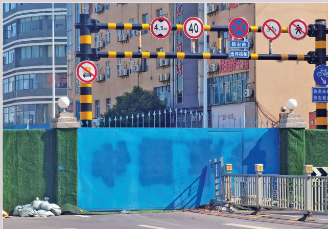
铁门上的施工方标识已经涂掉
