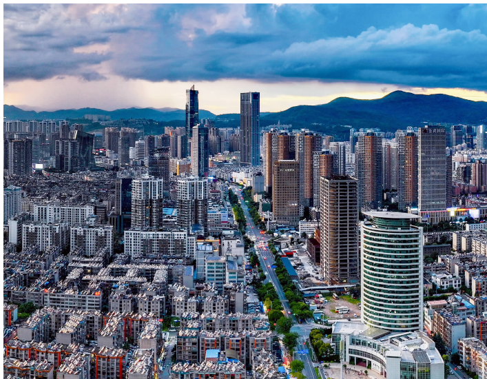
昆明城市风貌
