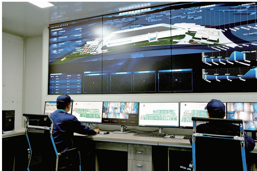
厂区各项生产数据在监控室显示屏上一目了然
