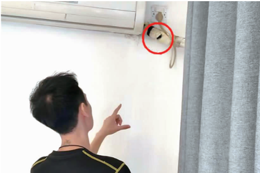
摄像头安装在空调和管道连接处(视频截图) 网络截图
