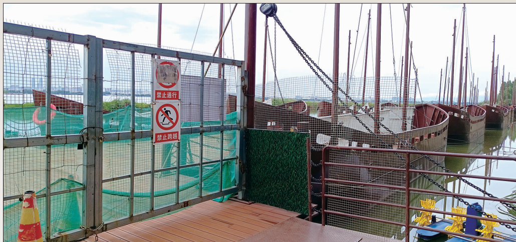
6月29日，帆船浮桥仍处于围挡封闭状态
