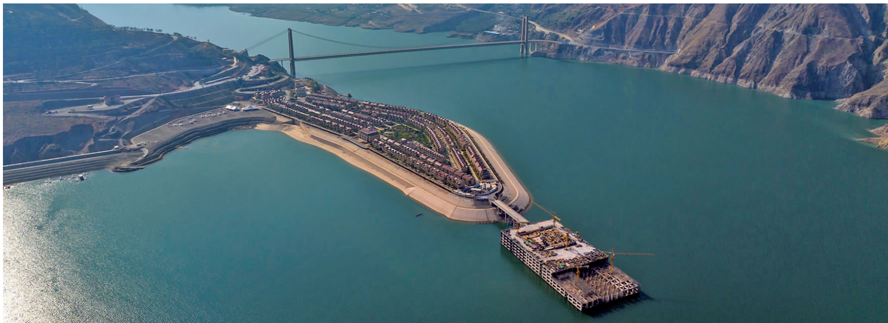
建设中的东川港客运码头(摄于 2023 年 12 月)
