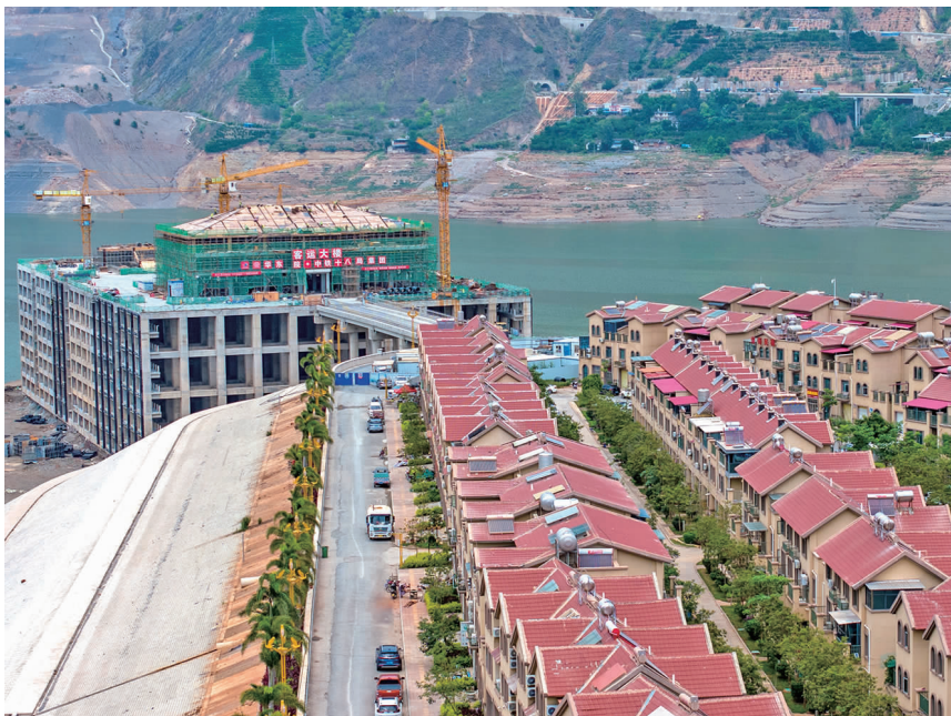
东川港格勒旅游客运中心工程,共3个400客位客运泊位(摄于6月21日)
