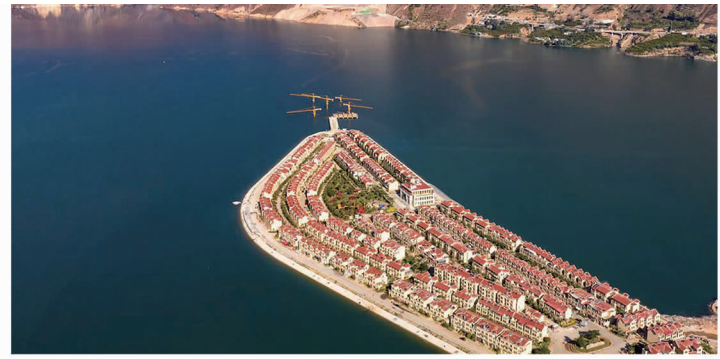
2022年11月,建设中的东川港旅游客运中心
