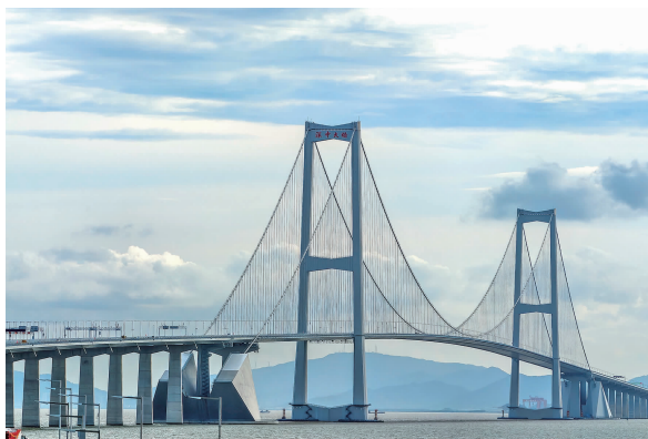
静待通车的深中通道深中大桥(6月29日摄) 新华社记者 刘大伟 摄
