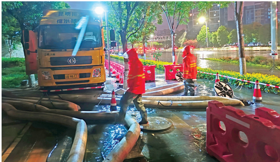
防汛队员处置道路淹积水 昆明排水公司 供图
