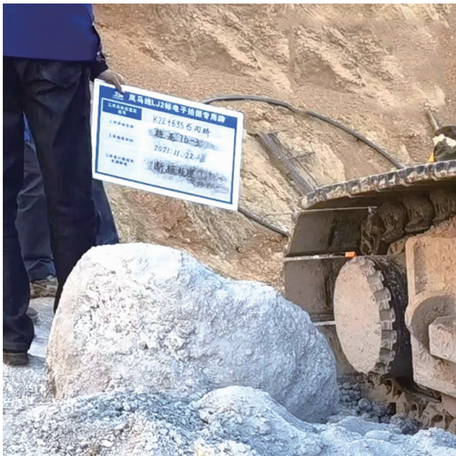
断桩处理现场 本版图片 举报人提供
