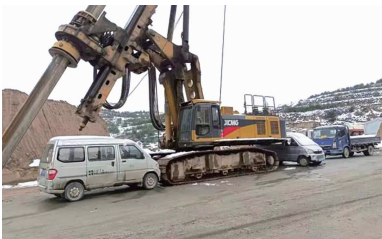
停在施工现场的旋挖机
