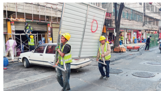
施工人员正在拆除围挡
