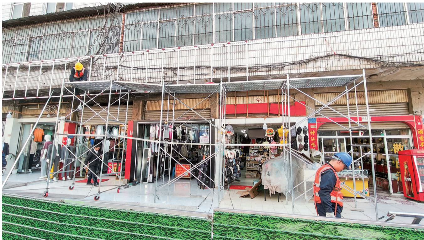
施工人员正在围挡内作业
