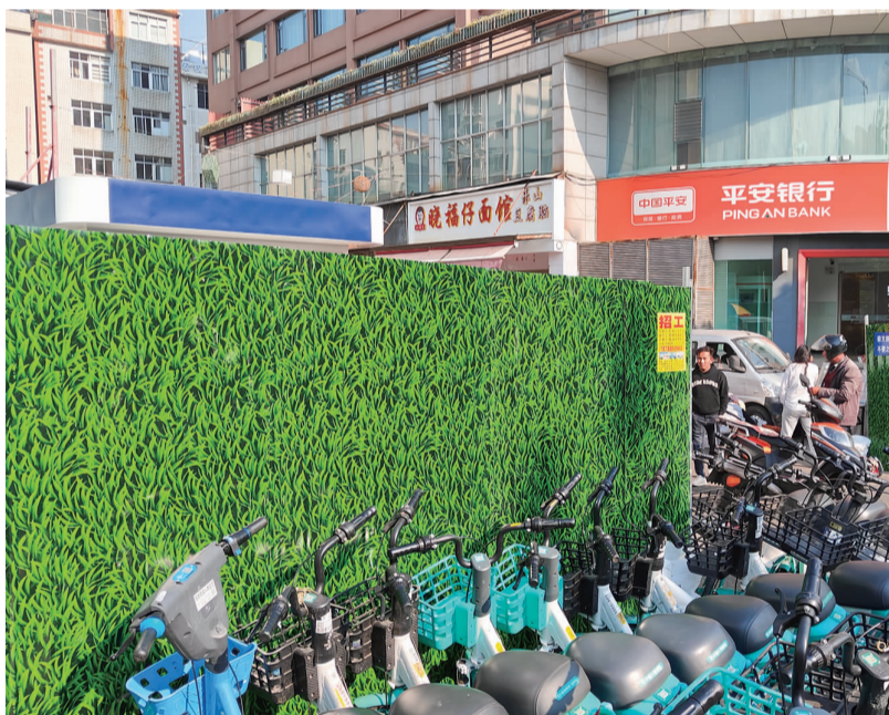
福德站C口处已架起围挡
