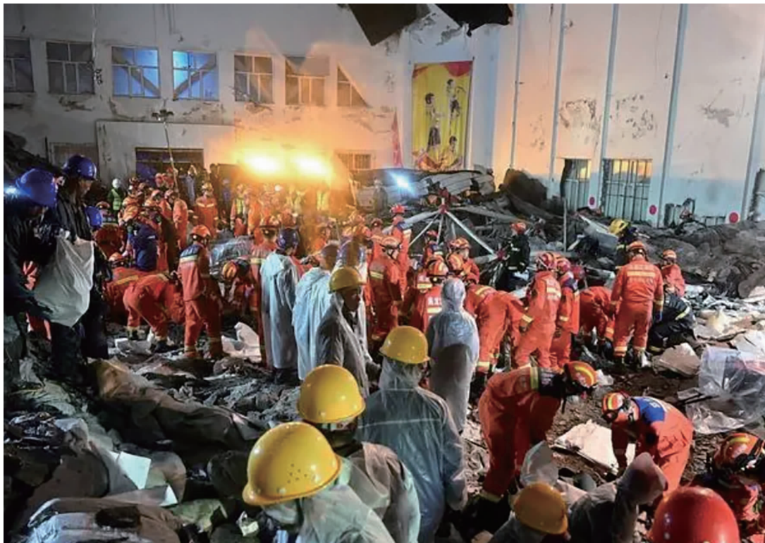
“7·23”体育馆屋顶坍塌事故救援现场 新华网 图
