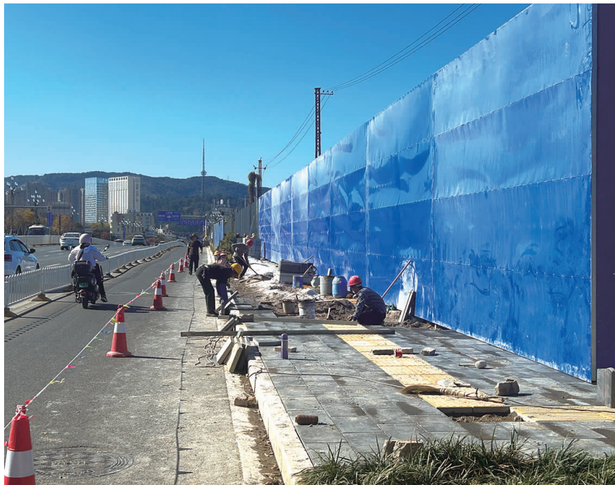
原本的围挡已拆除约100米,施工人员正在铺设地砖
