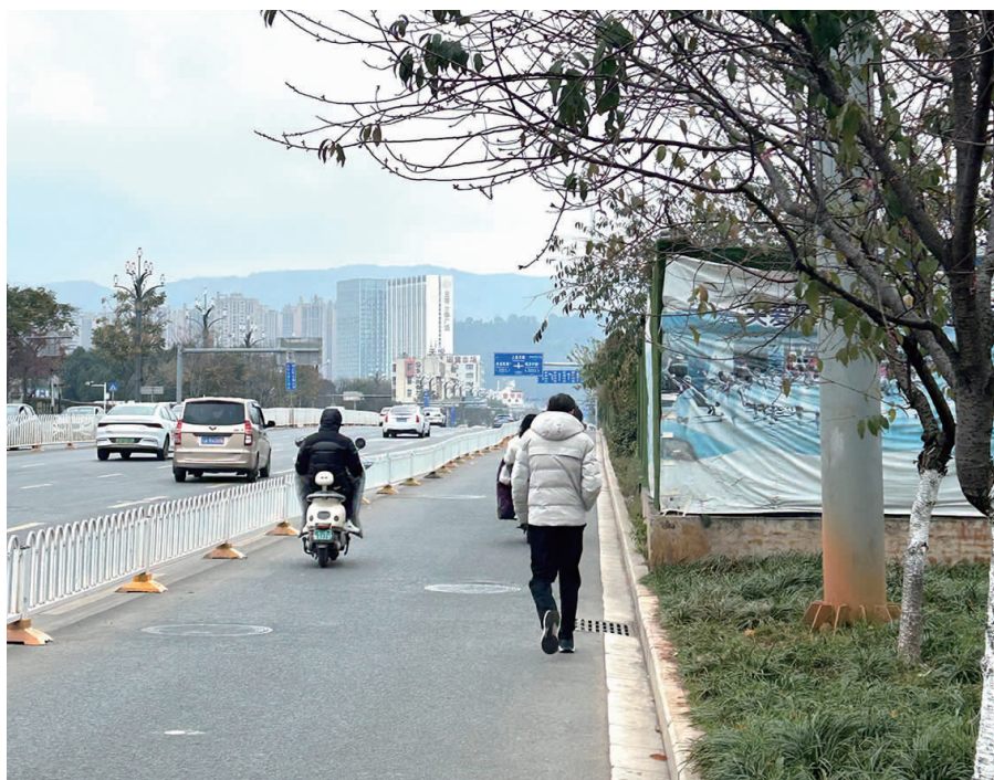
围挡拆除前,市民只能借非机动车道通行 本组图片 都市时报全媒体记者 何梦捷
