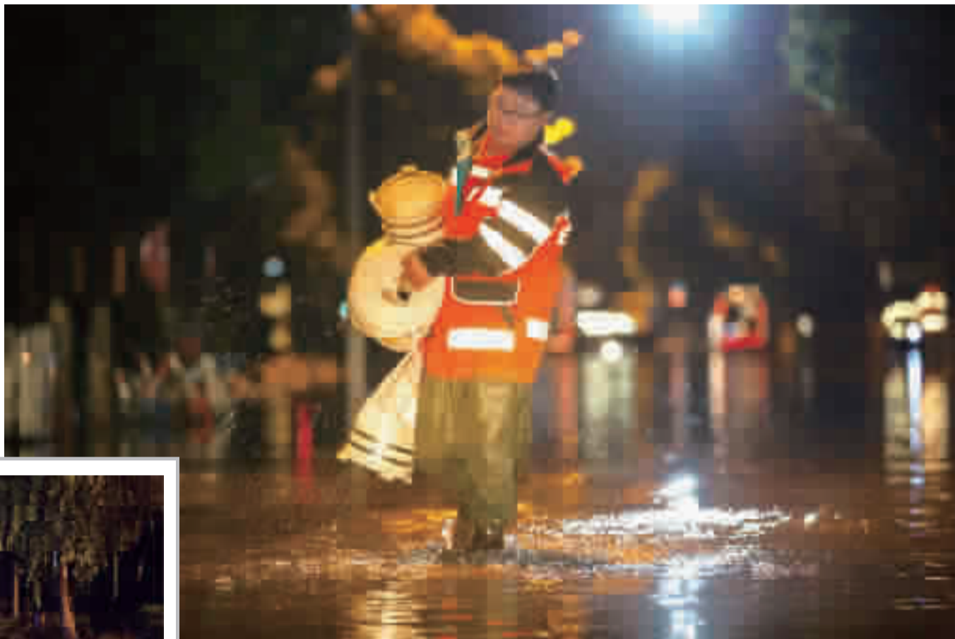
排水工人在闸口路铺设抽水水带
