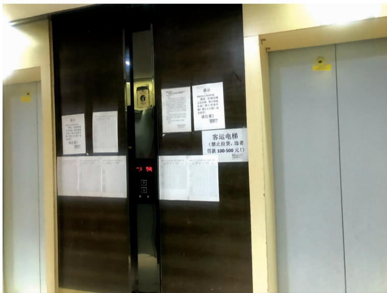
发生过两次事故的电梯 都市时报全媒体记者 董佳妮
